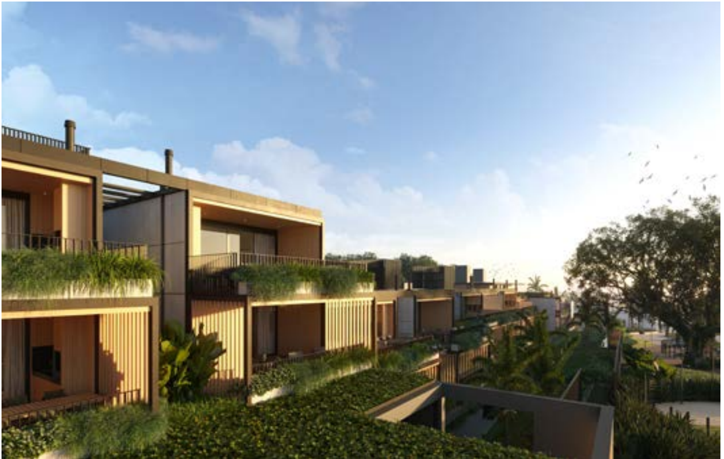
Fachada viva: mais do que se integrar à natureza, deixar a natureza entrar.
